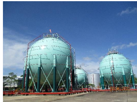
ภาพที่ 2-20 ระบบฉีบน้ำดับเพลิงบริเวณถังเก็บ ก๊าซปิโตรเลียมเหลว
